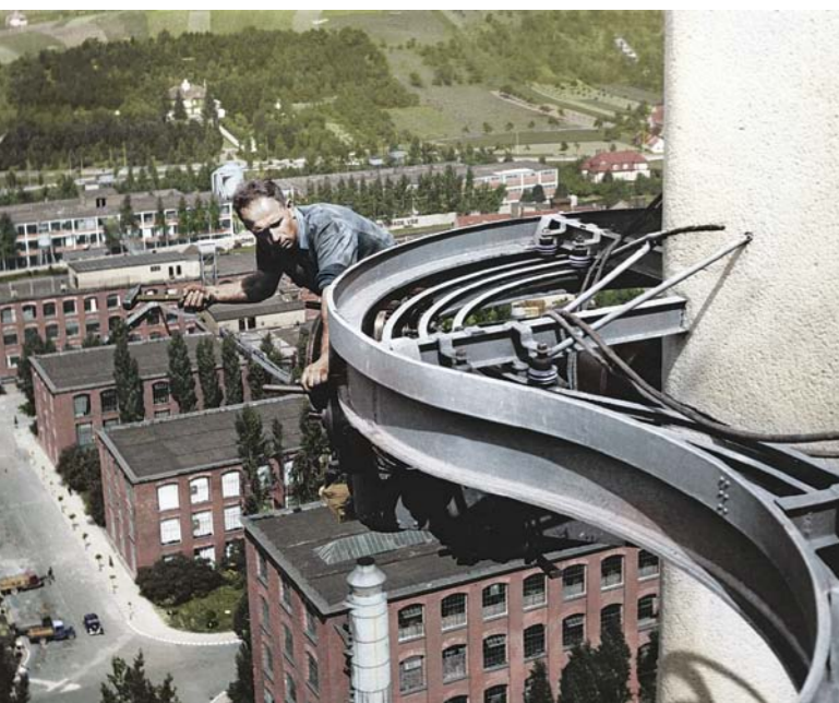
Výstavba 21. správní budovy/Construction of No. 21 Administration Building
